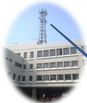
消防本部無線基地局
