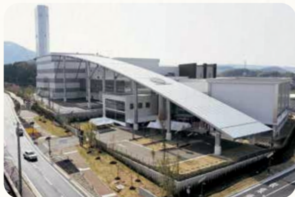
今治市クリーンセンター「バリクリーン」
