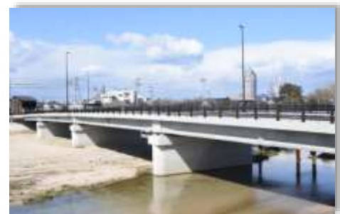
榎橋 (令和2年3月架替完了)
