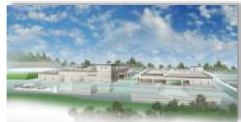
(仮称) 高橋浄水場 (令和3年度完成予定)
