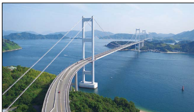
広域的な水融通（来島海峡大橋）
