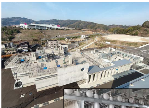
（高橋浄水場 前処理施設）
