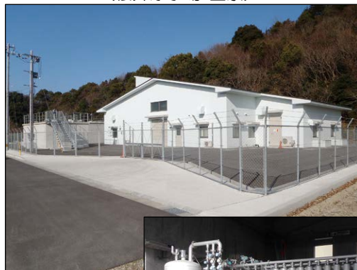
（桜井浄水場 全景）
