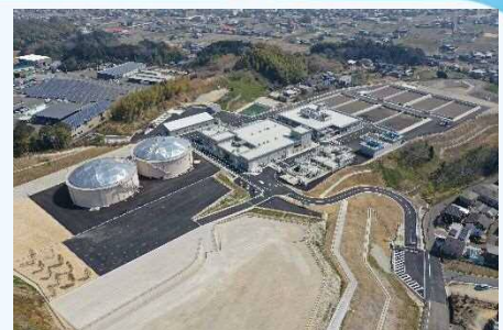
(高橋浄水場全景)
