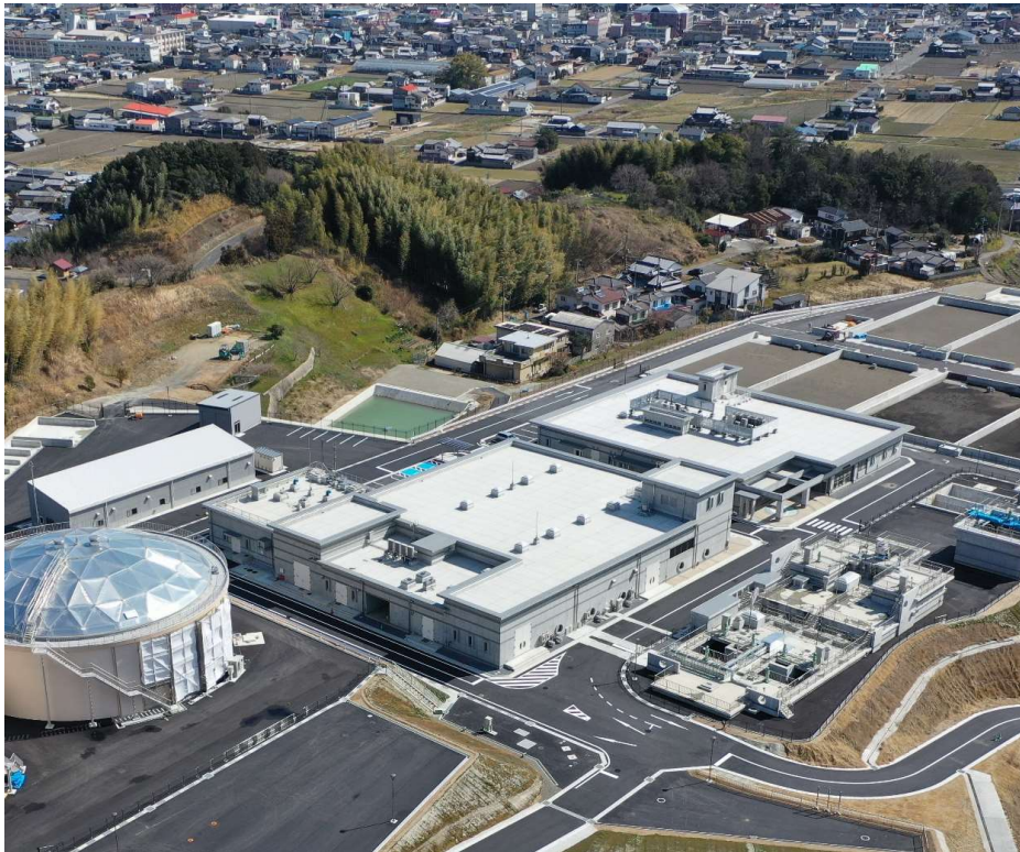
高橋浄水場 (バリウオーター)
