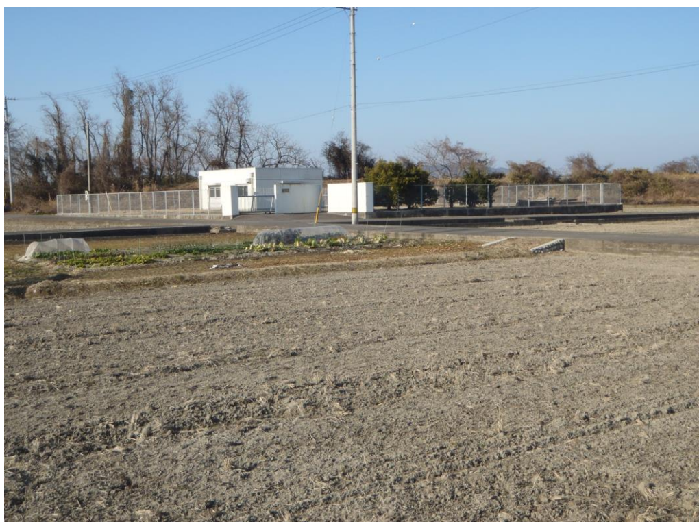
(今治市玉川八幡浄水場)
