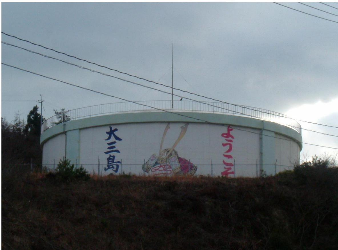
(大三島配水池)
