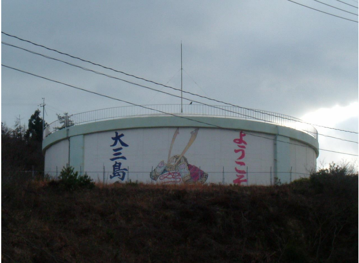
(大三島配水池)
