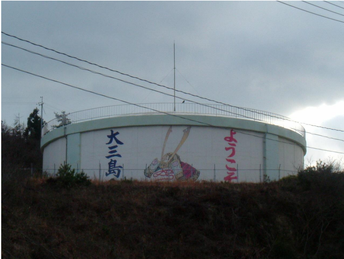
(大三島配水池)
