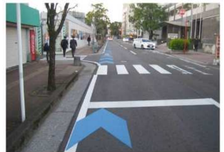
車道混在の事例
