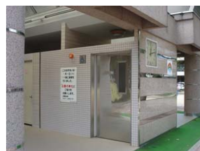
〔多機能トイレの設置〕
