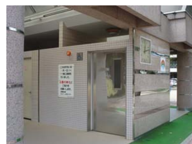
〔多機能トイレの設置〕
