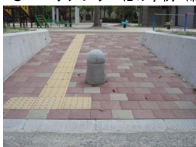
〔出入口の段差等の改善〕
