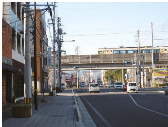
▲常盤町踏切（高架後）
