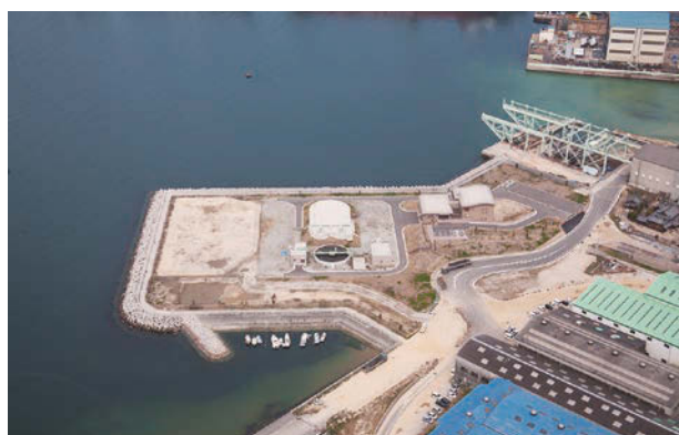
▲大西水処理センター
