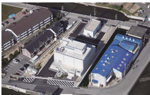
▲鳥生ポンプ場
